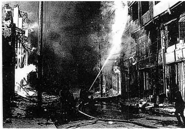
危険を冒して消火する重慶市民
